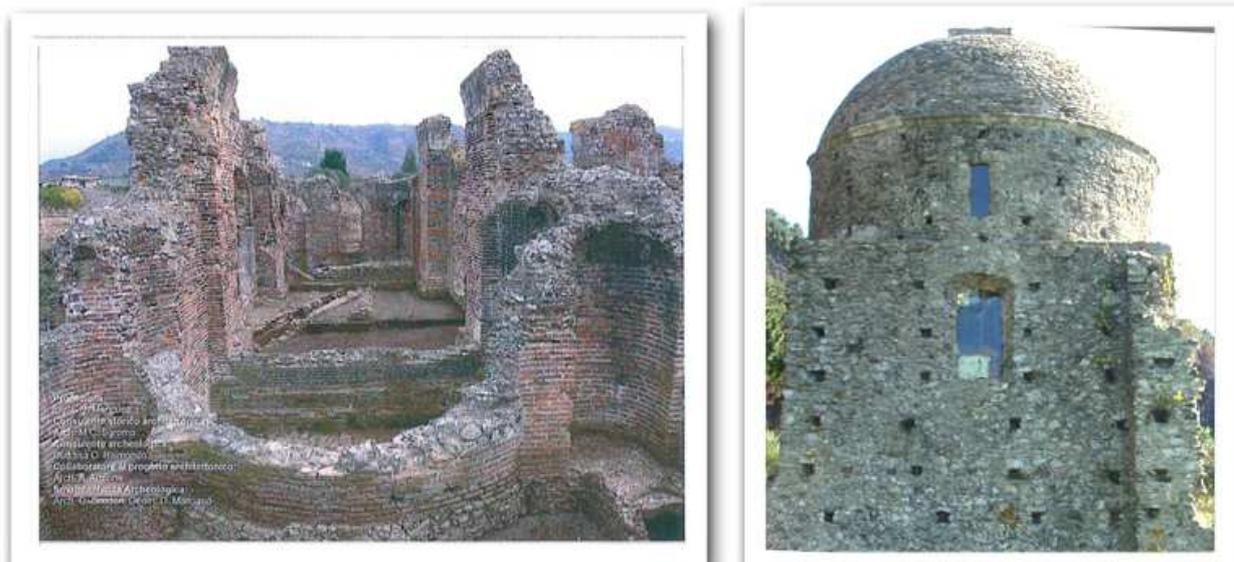
Figura 4. Le terme romane di Ellene a Curinga del I secolo d.C. (a sinistra) costruite in opera laterizia, e (a destra) la muratura in blocchetti di pietra locale dell'Eremo di Sant'Elia, tecnica tipicamente medievale (da Relazione 2013, Cuteri 2009).
